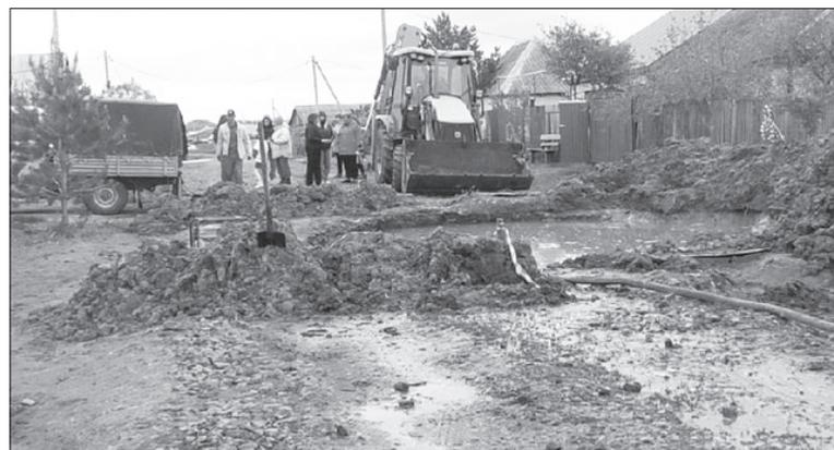
результате чего были повреждены водные коммуникации. Как следствие – постоянная наполняемость колодца, из-за которой топится часть улицы и проезжую часть.
